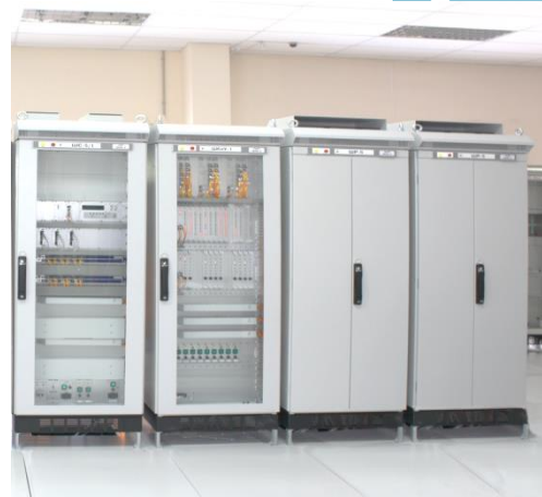
Устаткування МАБ-У для перегону Станишівка-Житомир
