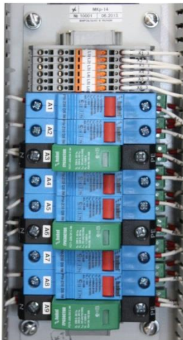
Модуль кросовий МКр-14 (модуль гроззахисту для трьох каналів, перший клас захисту)
