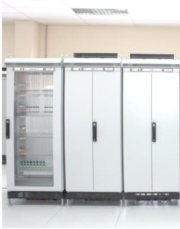
Устаткування МАБ-У для перегону Станишівка-Житомир
